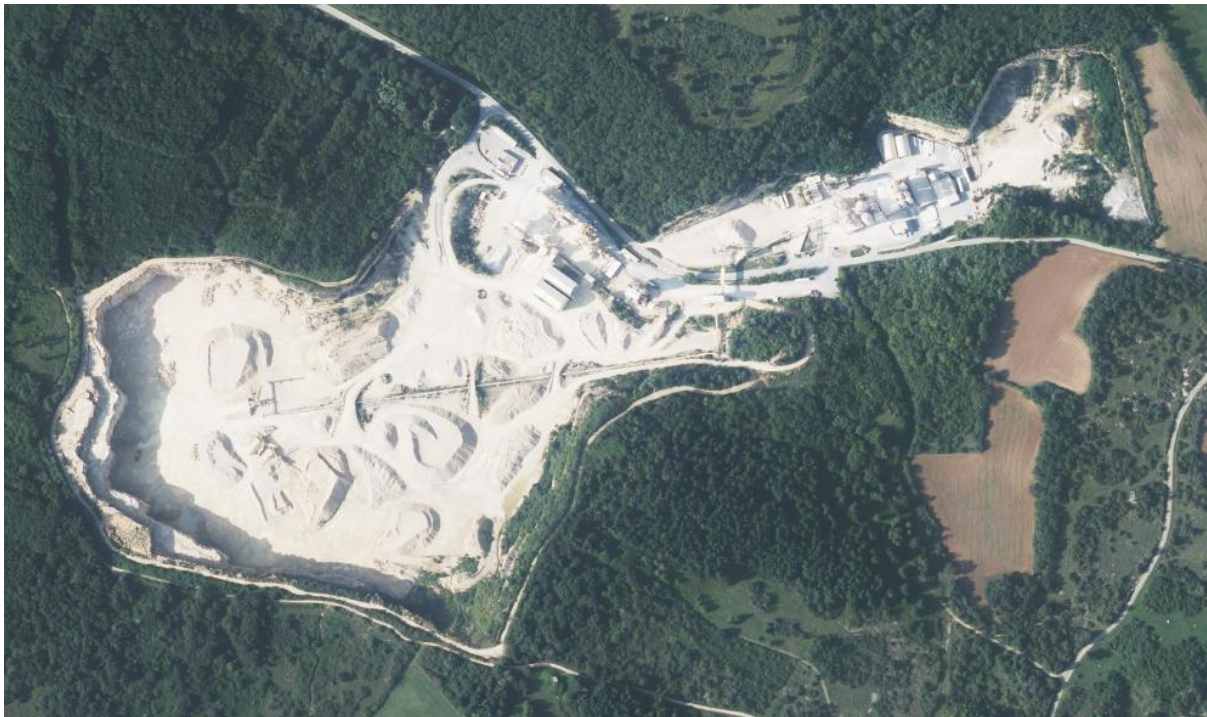
Carrière de la Gagne, Photographie aérienne issue e Géoportail
